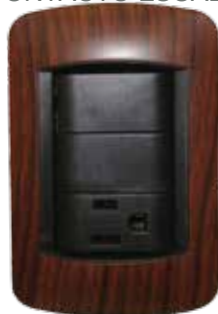
2 APAGADORES SENCILLOS Y 1 CONTACTO ESCALERA
